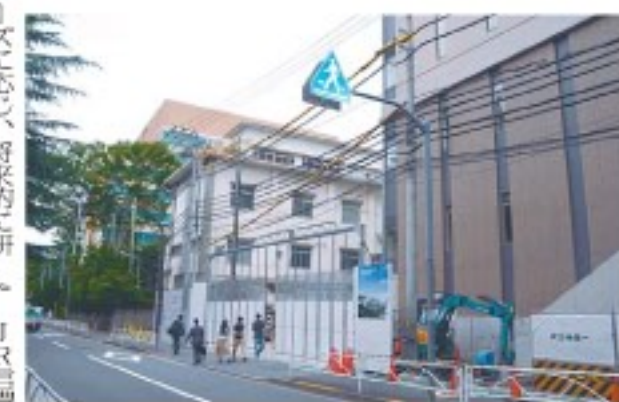
慶應大学病院も建替え 10階建ての新病院棟を建設
