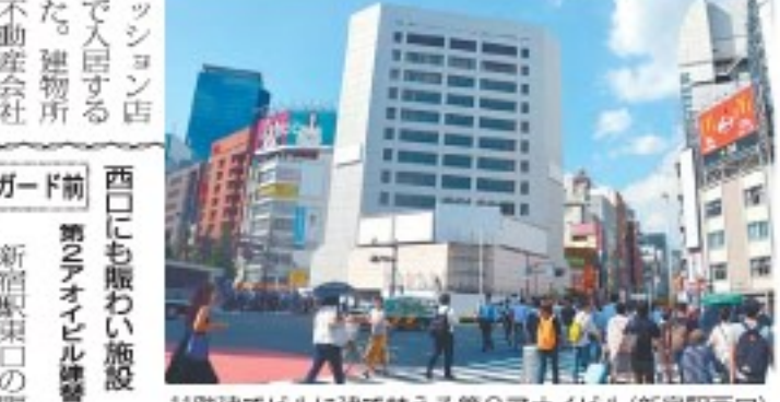
11階建てビルに建て替える第2アオイビル(新宿駅西口)
