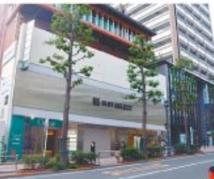
三生興産取得のリカビル(渋谷)は約1年かけて既存建物解体。その間に具体的な開発計画をまとめていく。その後、再開業事業に取り組み。
