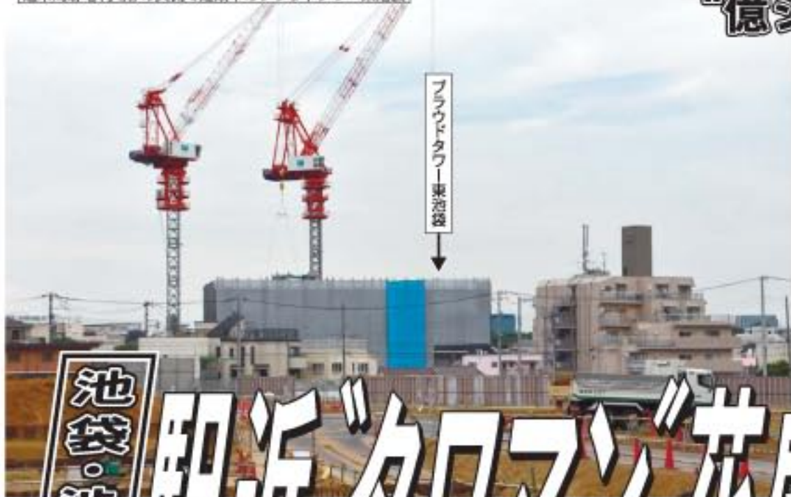
池袋駅跡地(手前)の奥側で建設中のプラウドタワー東池袋
