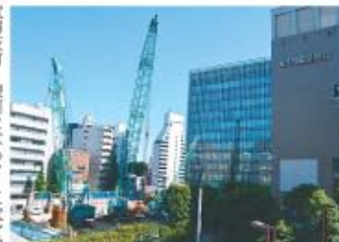
千駄ヶ谷5丁目地区では16階再開発ビルが建設中。地価は前年比で7.4%増と、都内でこの歌舞伎町に次ぐ伸びを示したのが新宿南口(渋谷区)だ。
