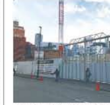
21階超高層ビルを建設する渋谷スタジオ
